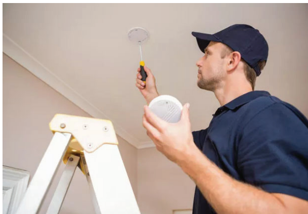
Slika 8: Montaža dimnih alarmov
